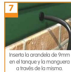
Inserta la arandela de 9mm en el tanque y la manguera a través de la misma.
